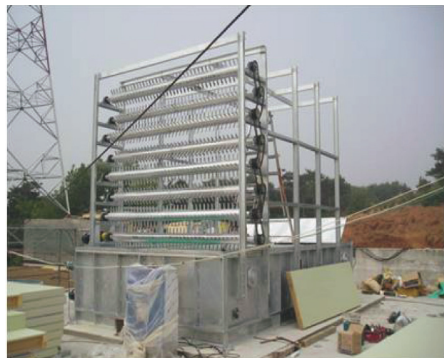
현장 조립 모습
